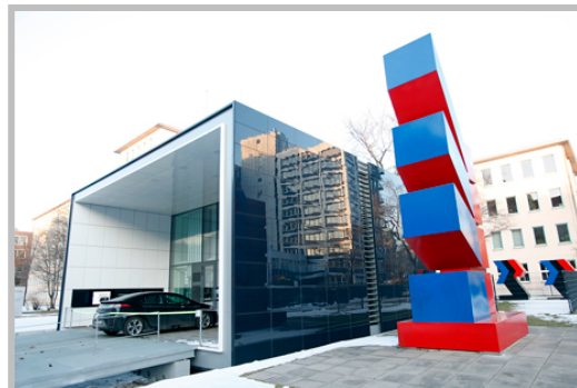
Das Effizienzhaus ist mit Fotovoltaik-Platten bedeckt. (Foto: "2° Campus")
